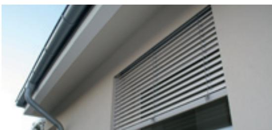
Il monoblocco è formato da un Cassonetto prefabbricato composto da schiuma di polistirene espanso a cellula chiusa auto estinguibile ad alta densità armato con struttura in acciaio, il che conferisce al cassonetto una particolare rigidità e resistenza. Spalle laterali prefabbricate coibentate composte da due pannelli: uno in polipropilene da 4mm di tamponamento l'altro in FIBROCEMENTO completi di profili in alluminio con
